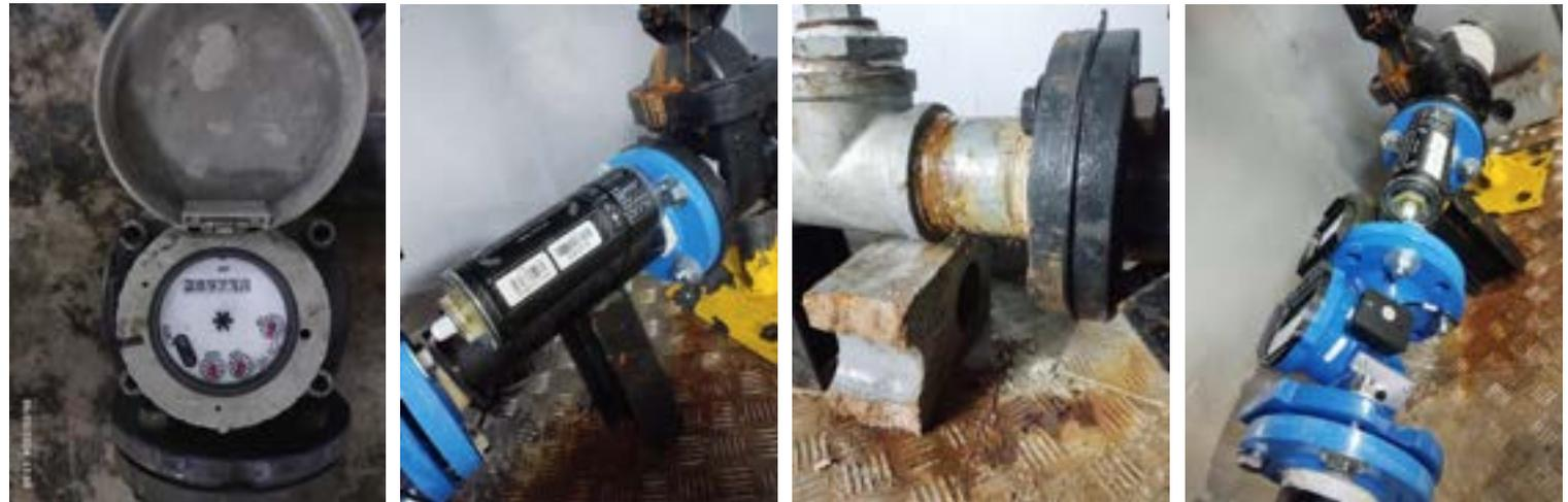
Se ejecutó el cambio de medidor de agua por una nueva tecnología, la cual permite seguimiento de consumos hora a hora y una mayor precisión en la liquidación del servicio público.
